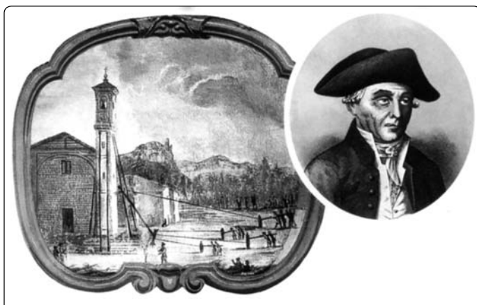
Dobová kresba zachycující posunování zvonice, vpravo podobizna zedníka Crescentina Serra, který posun naplánoval a uskutečnil
